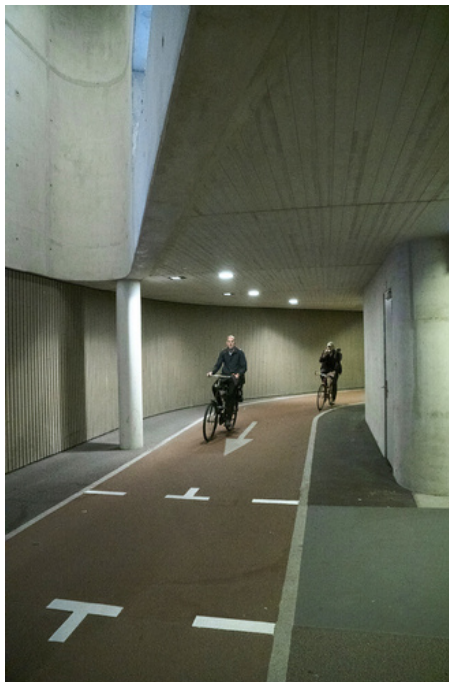
Jan Vorlíček Fietspad naar fietsenstalling Stationsplein Utrecht Parkoviště pro kola, Utrecht
